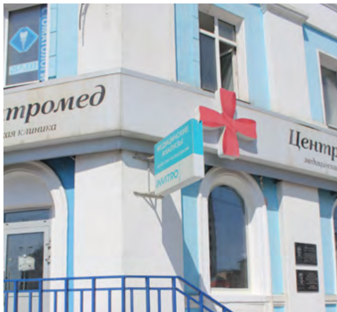
✗ Плохо. Крепление панели-кронштейна к архитектурным деталям
