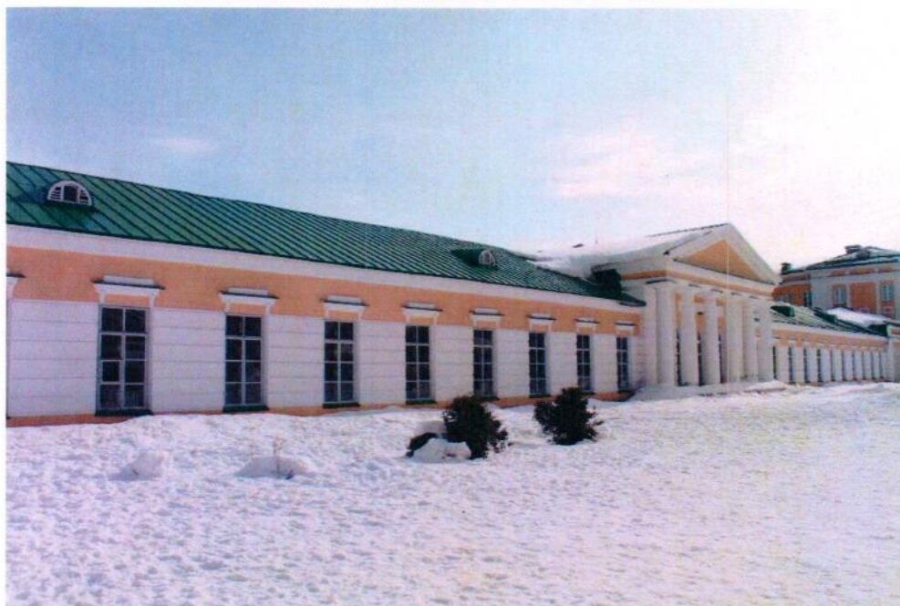
Западный фасад здания.
