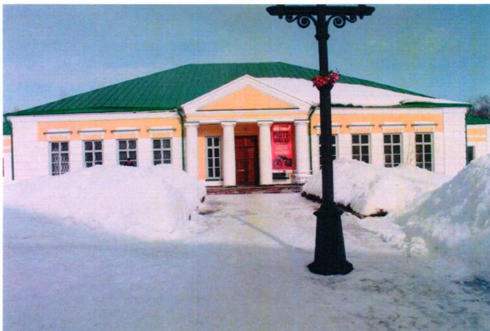
Южный фасад (внутренняя территория).
