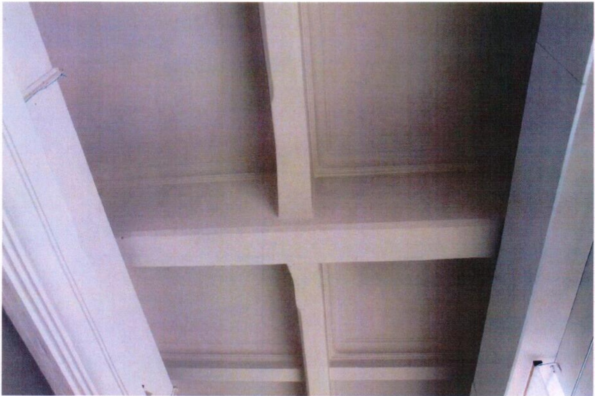
Фотофиксация кессонных перекрытий.
