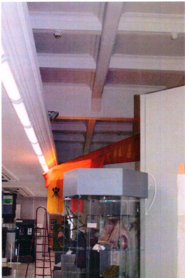
Фотофиксация кессонных перекрытий
