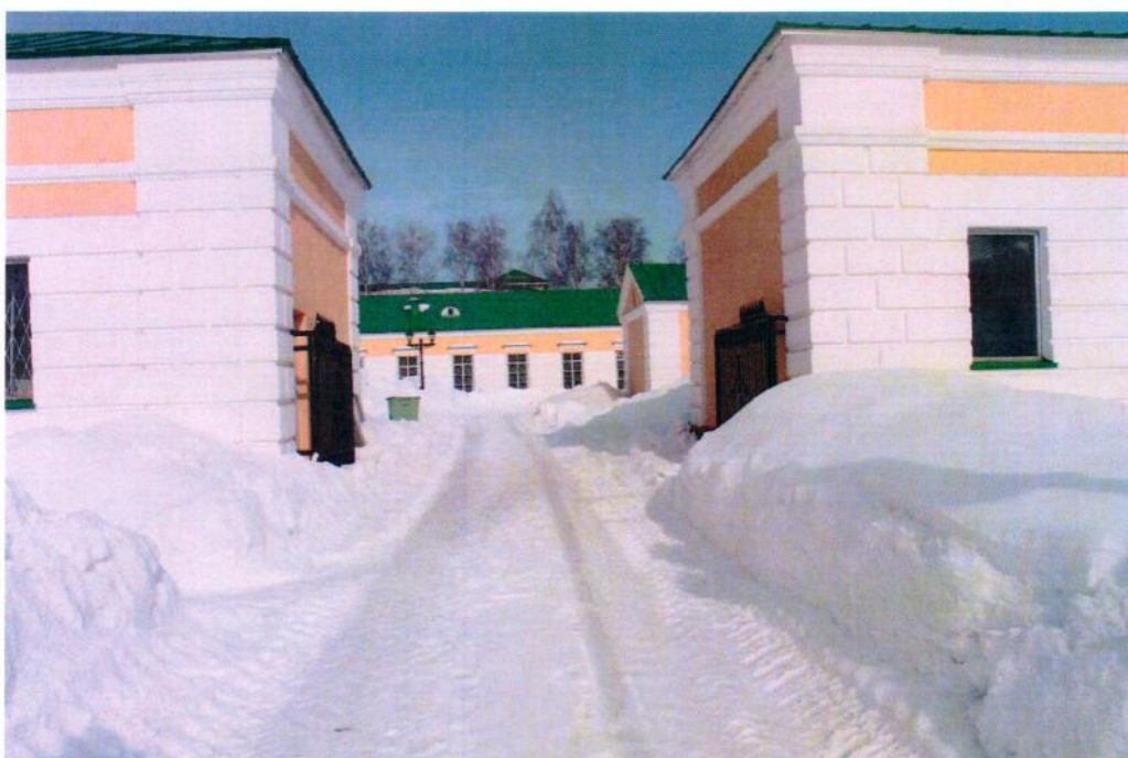
Фото внутреннего двора. Вид с южной стороны
