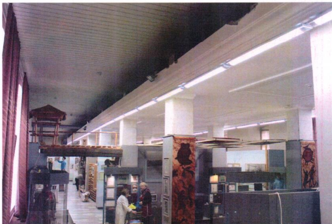
Фотофиксация потолочного покрытия экспозиционного зала № 2
