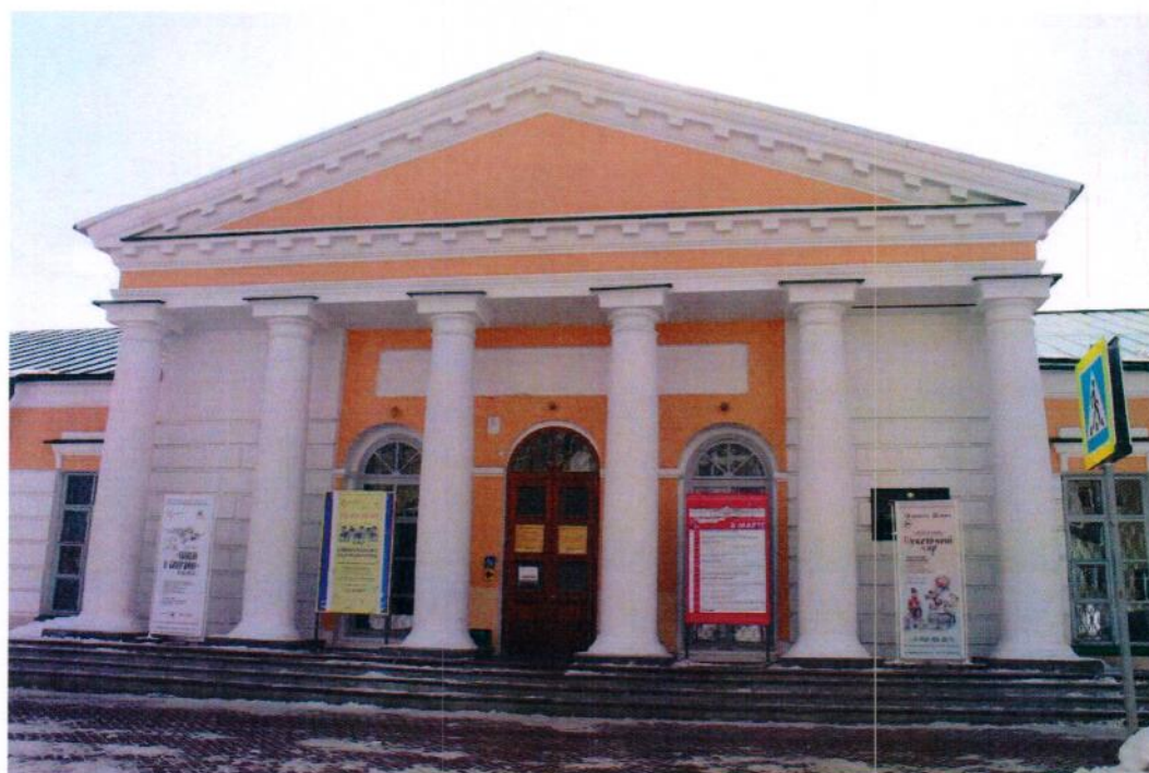
Северный фасад здания.
