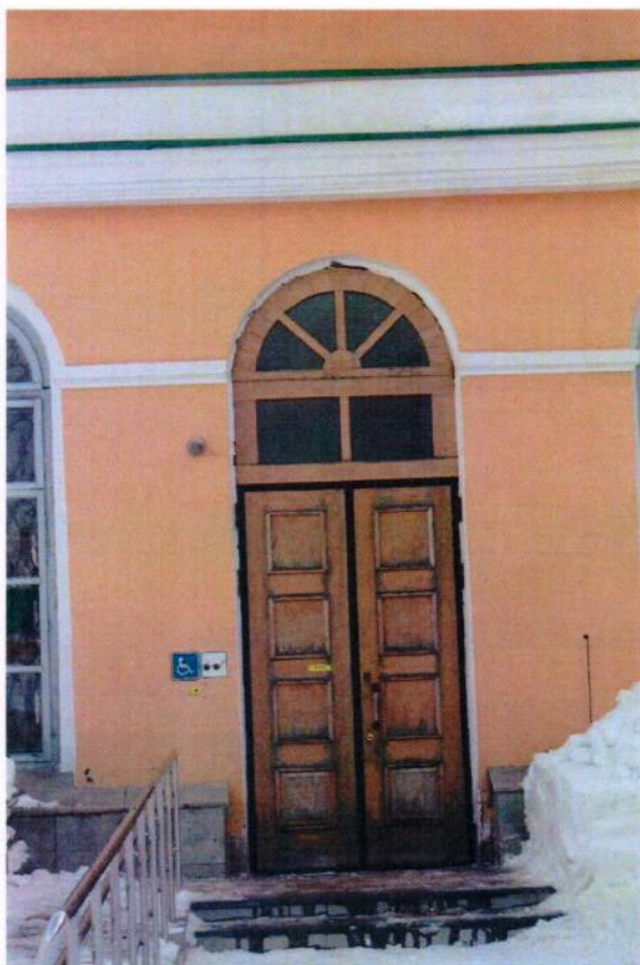
Фотофиксация намокания дверей и гниения нижних частей.
